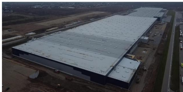
BUDOWA MEDIA EXPERT
