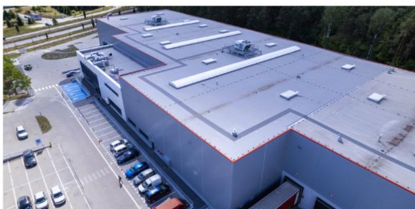
HALA PRODUKCYJNO-MAGAZYNOWA W ŁÓDŹ
