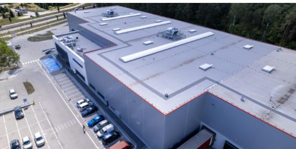
HALA PRODUKCYJNO-MAGAZYNOWA W ŁÓDŹ
