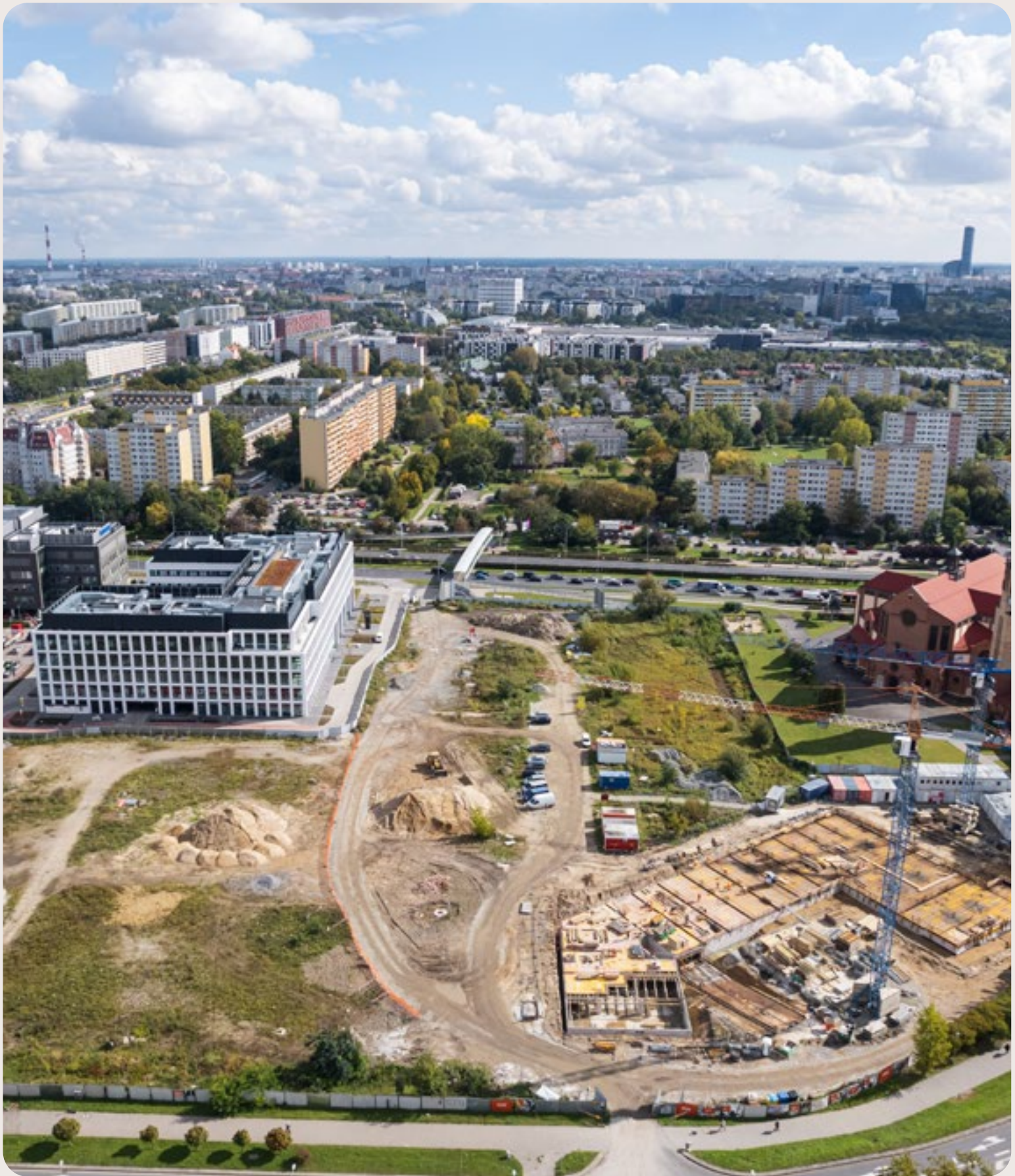
Fot. Budowa biurowca West 4 Business Hub we Wrocławiu
