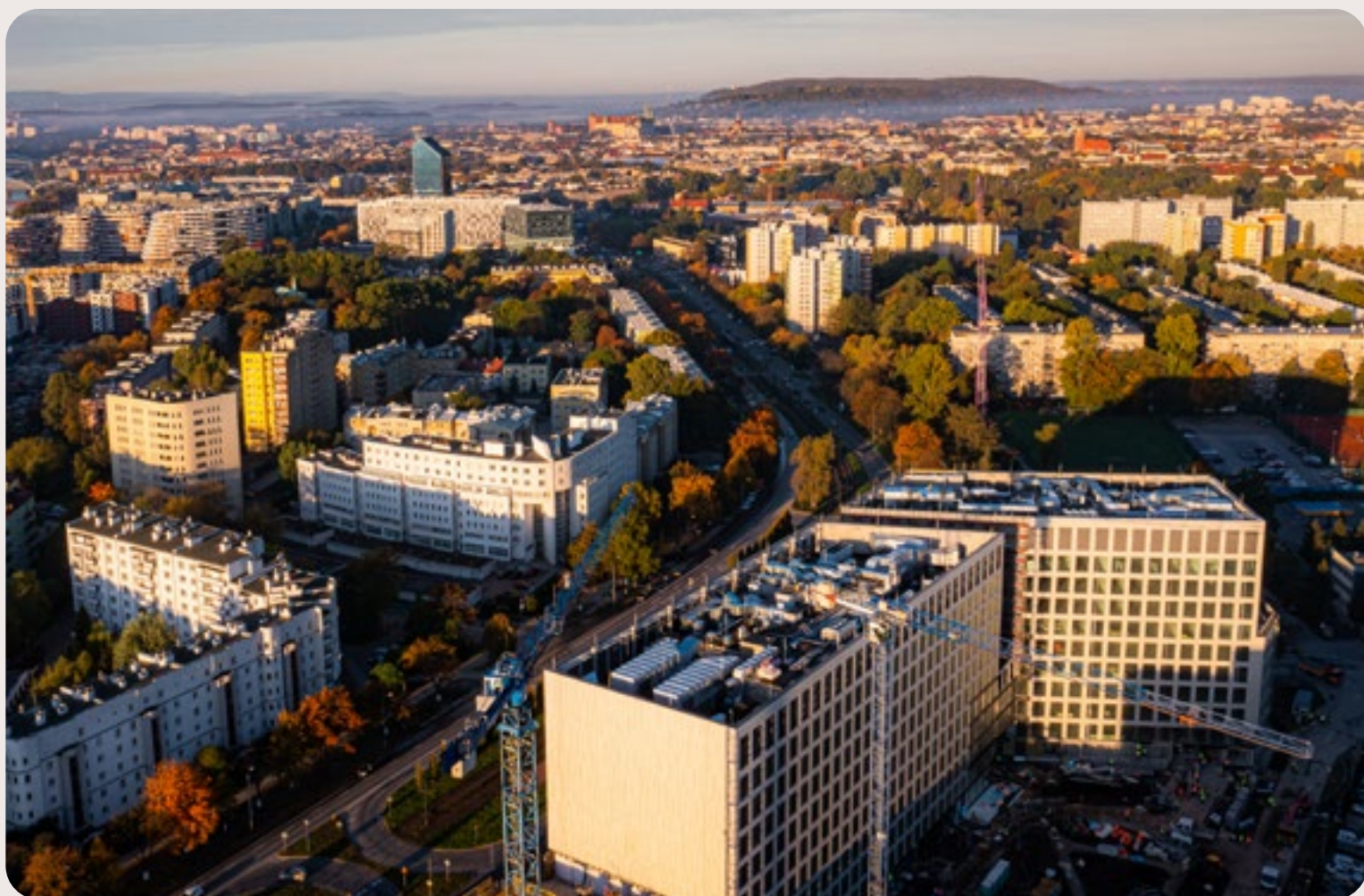
Fot. Budowa kompleksu biurowego Brain Park w Krakowie
