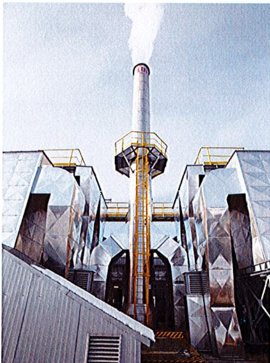
Układ odzysku energii i oczyszczania spalin
