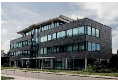
Siedziba AMK Kraków S.A
