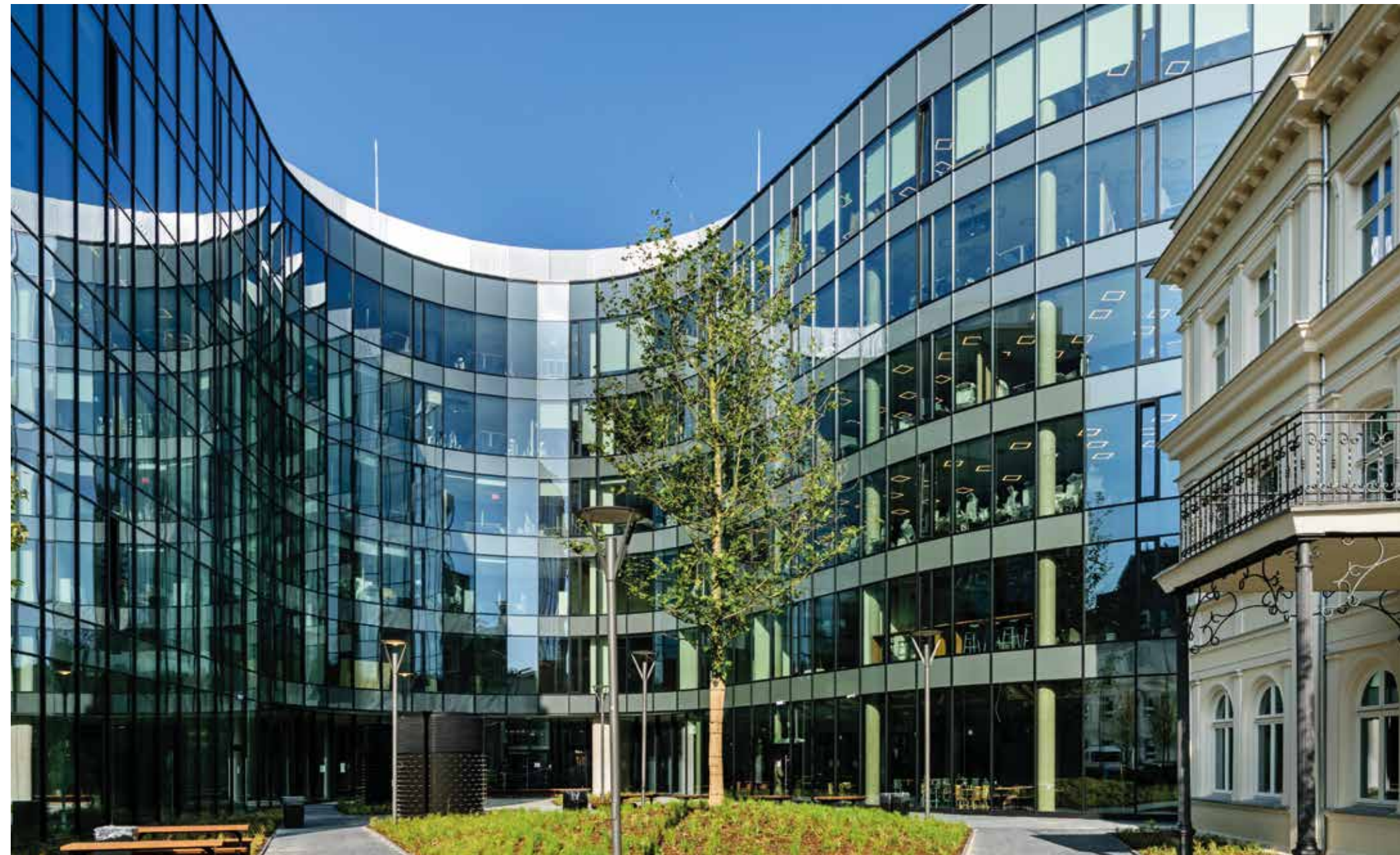
Biurowiec Przystanek mBank W Łodzi – certyfikat BREEAM, na poziomie VERY GOOD
