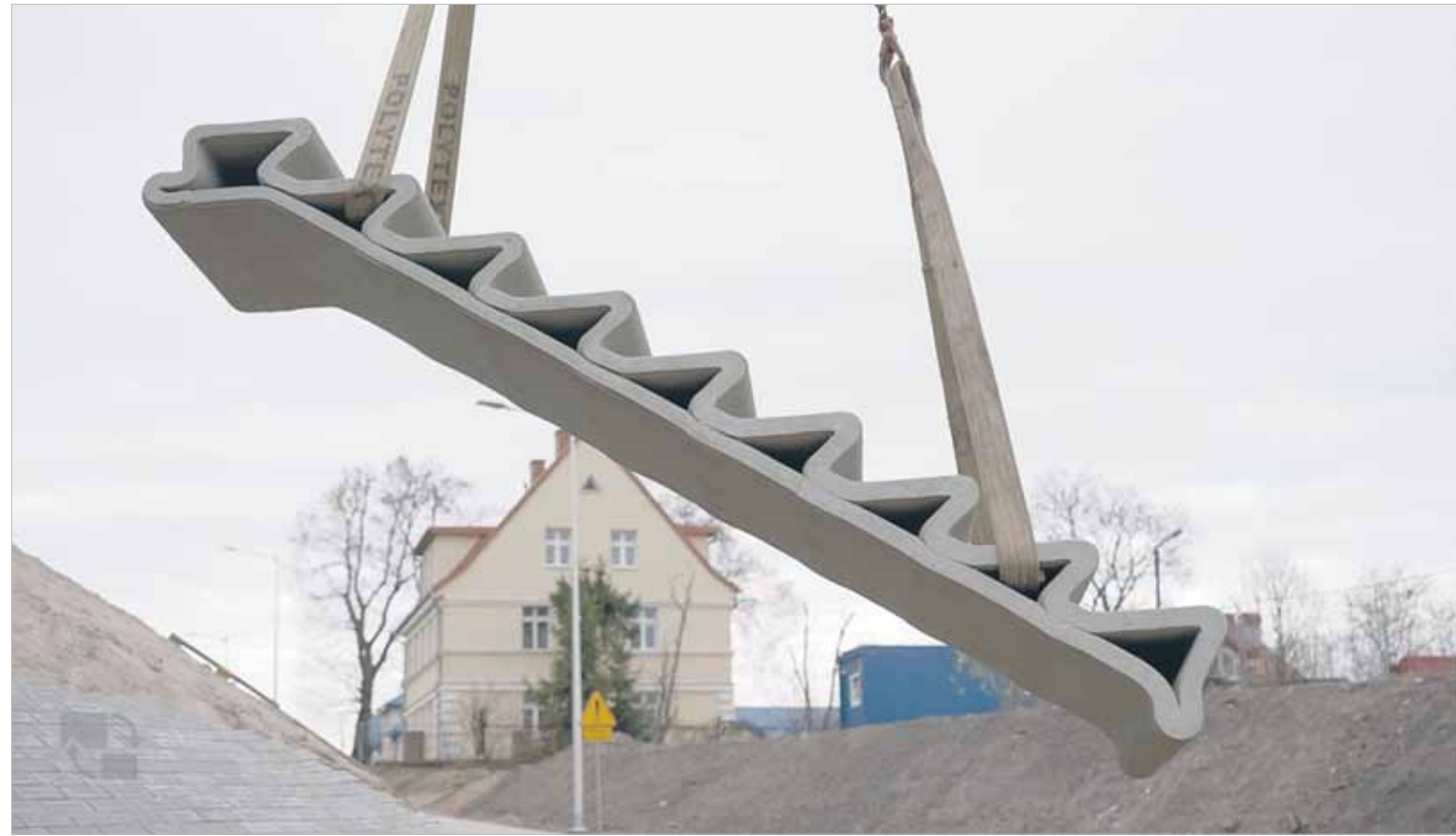
Schody wydrukowane w trójwymiarze i montowane na placu budowy w Elku mają 7 metrów długości i ważą niemal 2 tony
