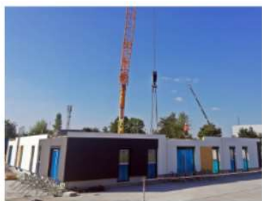
22-08-2018 Rozpoczęcie montażu budynków
