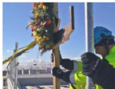
24-10-2018 Zakończenie montażu budynków
