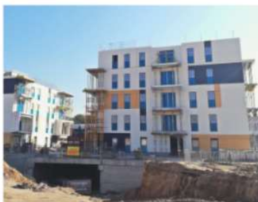
12-10-2018 Montaż ostatniej kondygnacji
