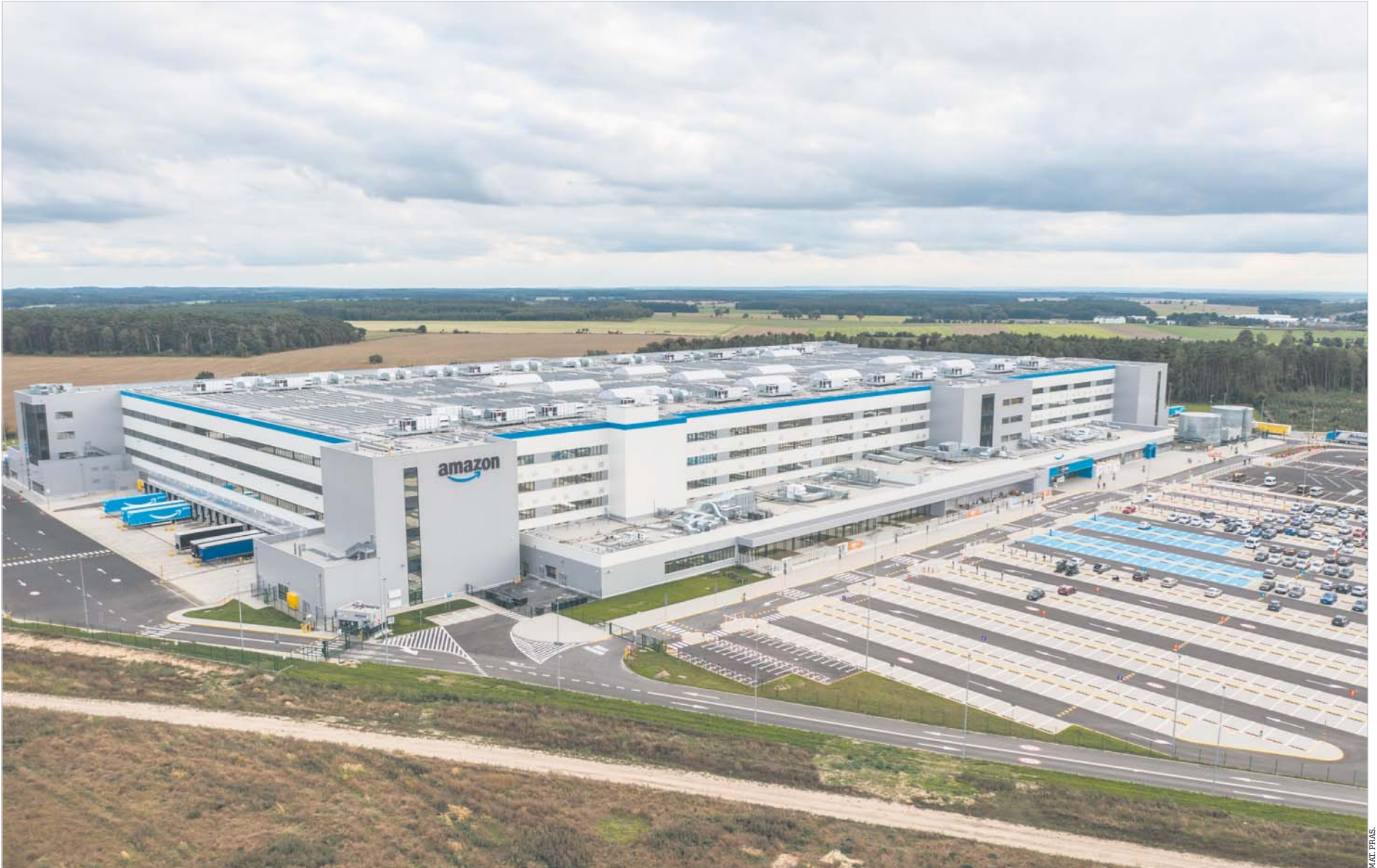
Centrum logistyczne Amazon w Świebodzinie – na jego dachu zainstalowano 3900 paneli słonecznych o powierzchni 8,6 tys. mkw. i łącznej mocy 1755 kWp. Pozwala to na częściowe zasilanie obiektu energią odnawialną
