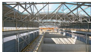
Budowa Hali Namiarowni Wsadu dla ZGH Bolesław S.A.
