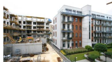
Budowa apartamentowców dla Vista Development Sp. z o.o.
