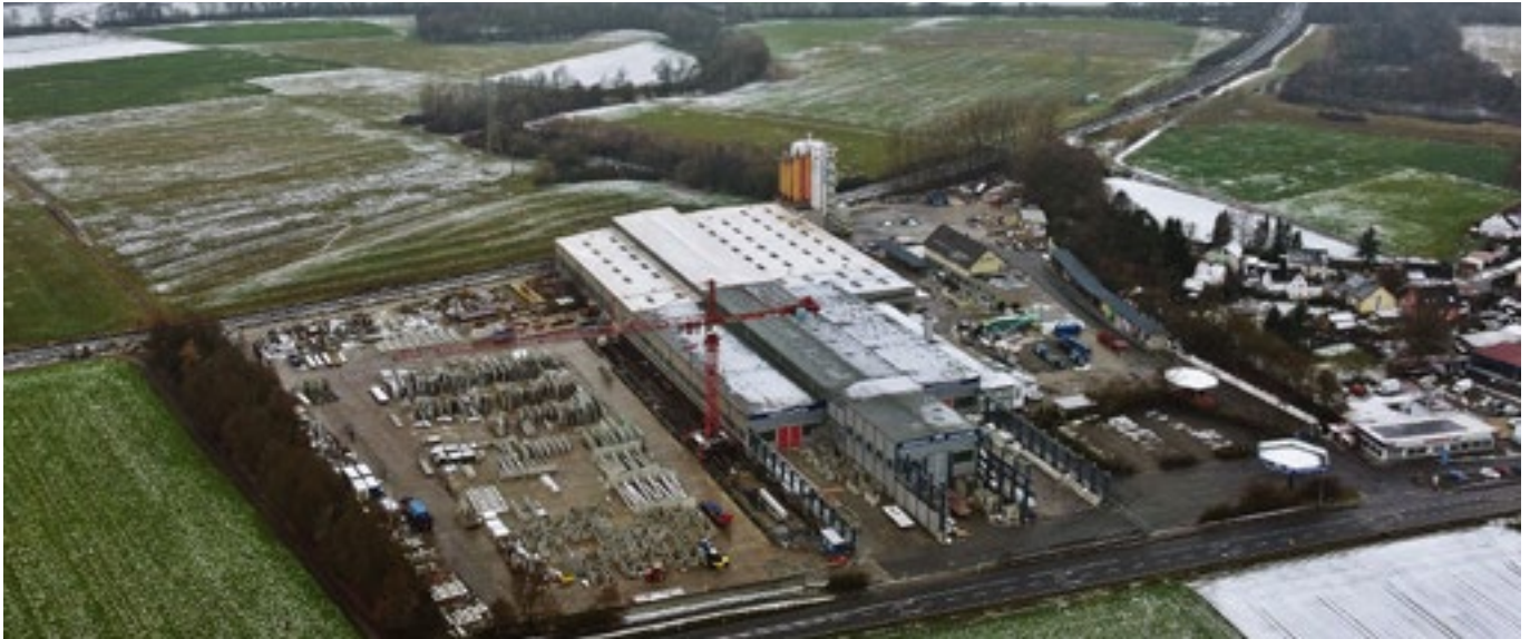
Fabryka FTO Fertigteilewerk Obermain (mat. Pekabex)
