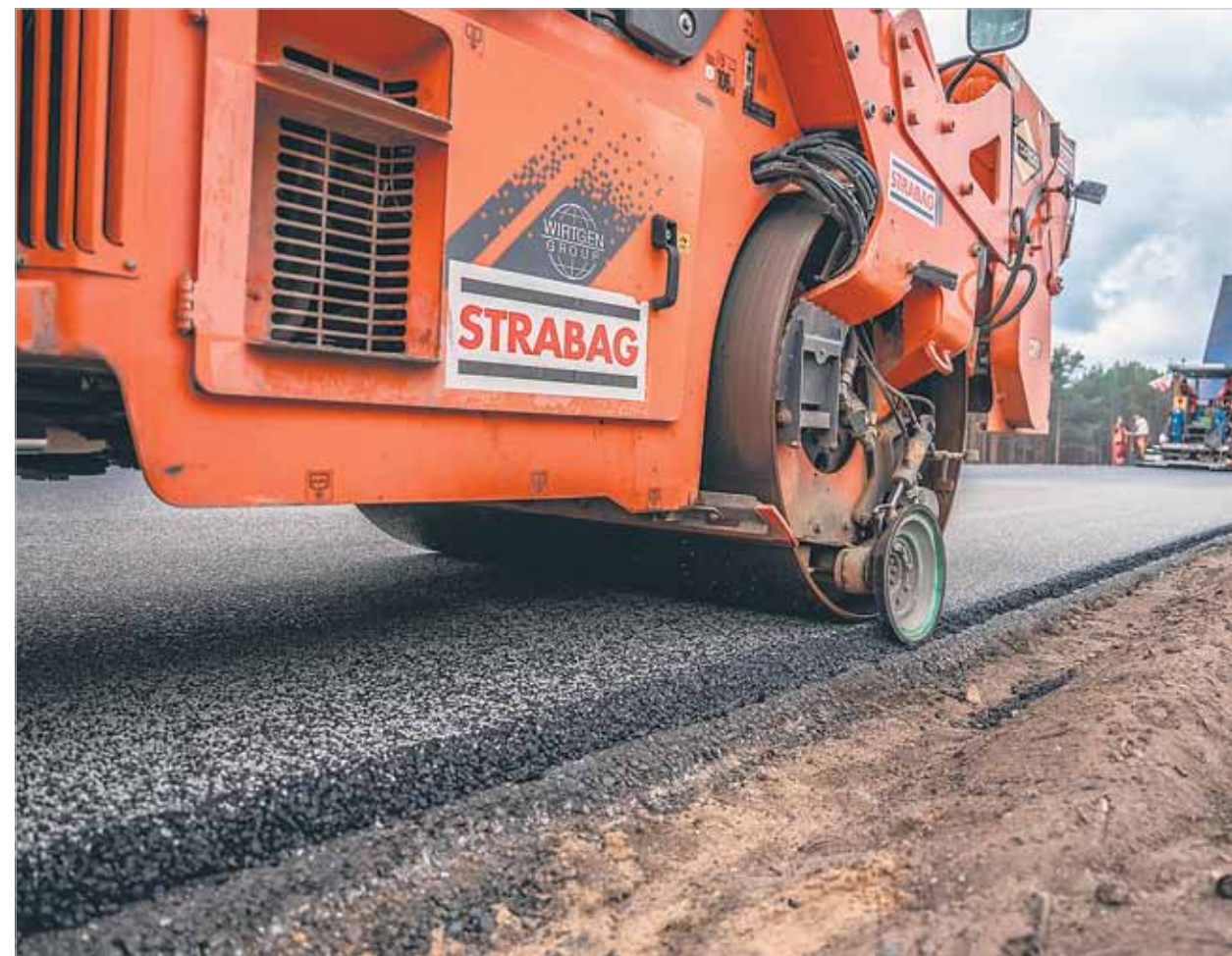
Innowacyjny recykling: STRABAG korzysta m.in. ze specjalnego asfaltu wykorzystującego przetworzoną gumę ze zużytych opon
