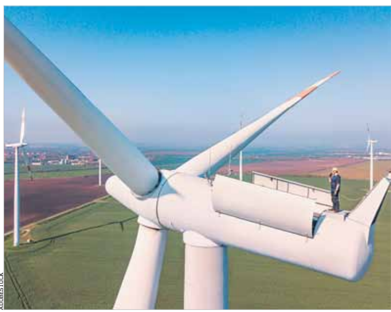
Moc farm wiatrowych to ok. 9,6 GW (wrzesień 2023 r.). Rekord chwilowej produkcji to ok. 7,9 GW, tj. ok. 82 proc. mocy zainstalowanej w tym źródle
