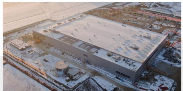
OBIEKT PRODUKCYJNY SIEMIANOWICE ŚLĄSKIE
