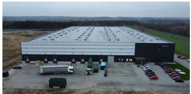
BUDOWA HAL MAGAZYNOWYCH W RAWIE MAZOWIECKIEJ
