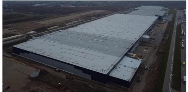
BUDOWA MEDIA EXPERT
