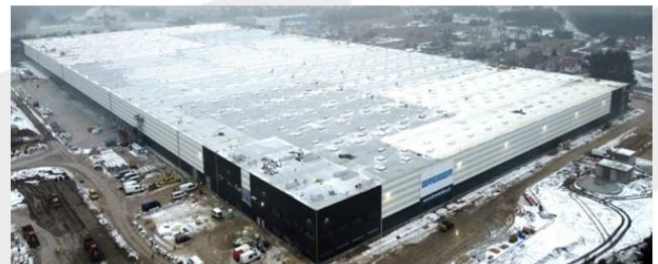
DOSTAWA I MONTAŻ POKRYCIA DACHU ZALANDO
