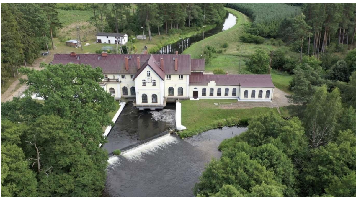
Elektrownia Wodna Żelkovo
