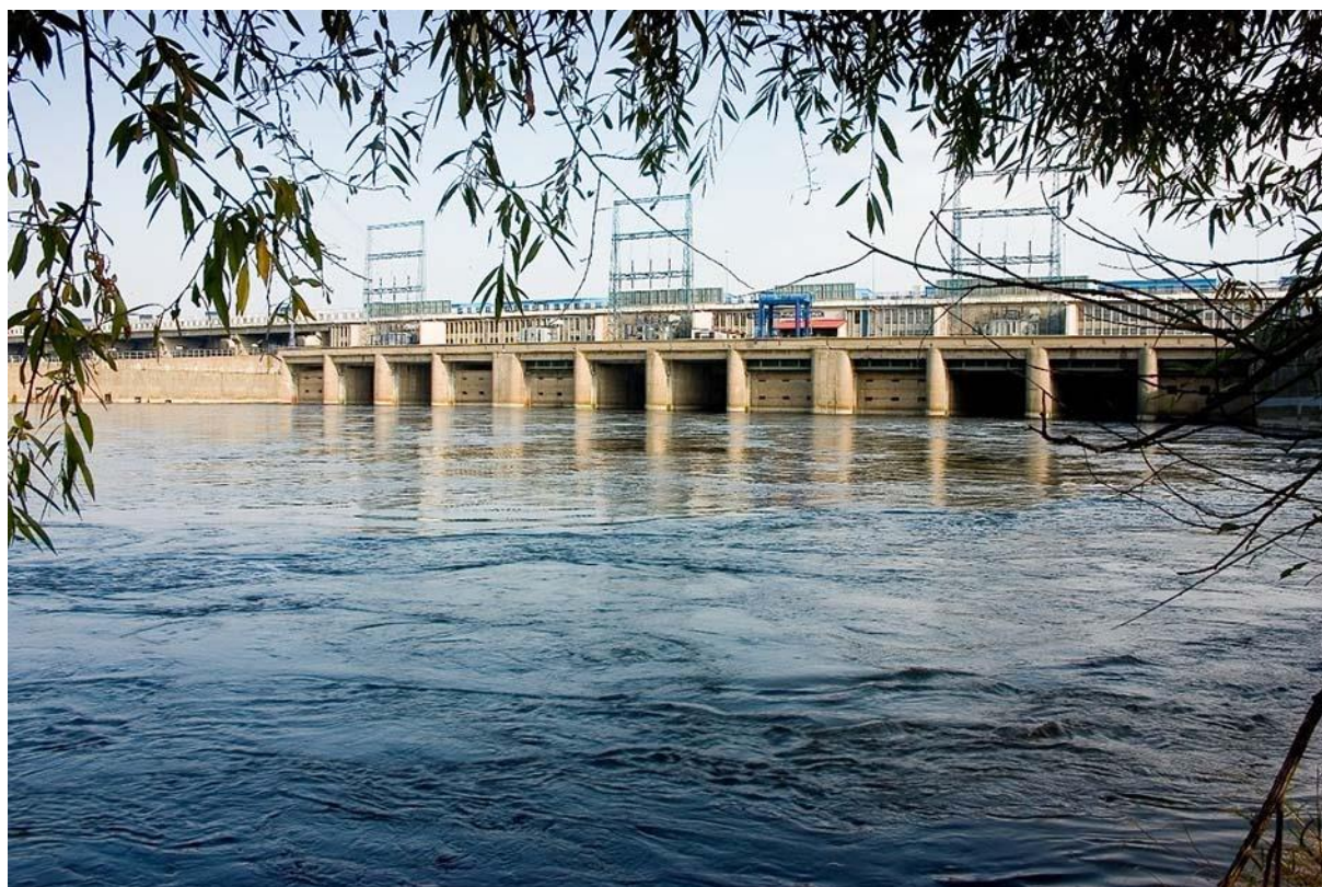
Elektrownia Wodna we Włocławku
