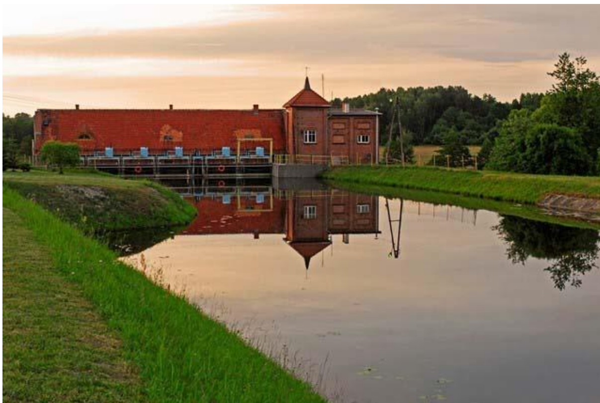
Elektrownia Wodna Pierzchały
