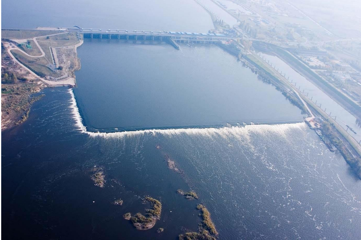
Elektrownia wodna we Włocławku
