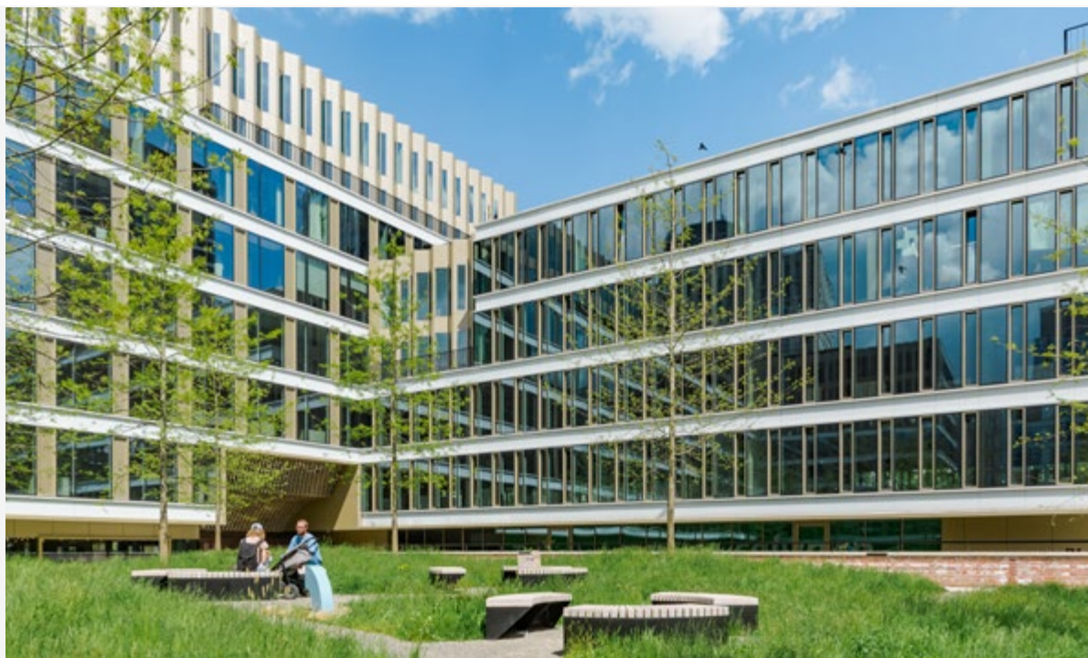
Budynek Biura przy Warzelni w kompleksie Browarów Warszawskich
