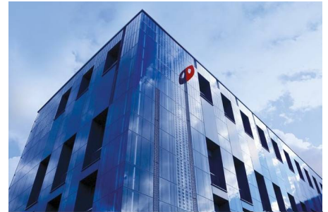
Kielecki Park Technologiczny – fotowoltaiczna fasada wentylowana
