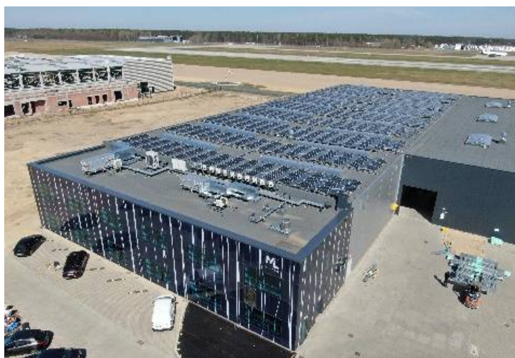
Siedziba firmy ML System – fasad wentylowana z użyciem druku ceramicznego o wysokiej rozdzielczości.
