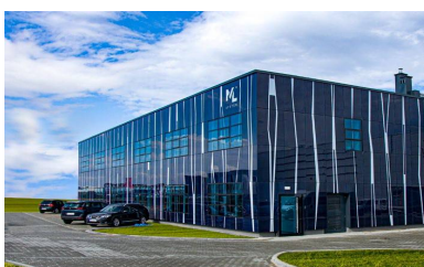
Nowy budynek ML System – fasada wentylowana z użyciem druku ceramicznego wysokiej rozdzielczości
