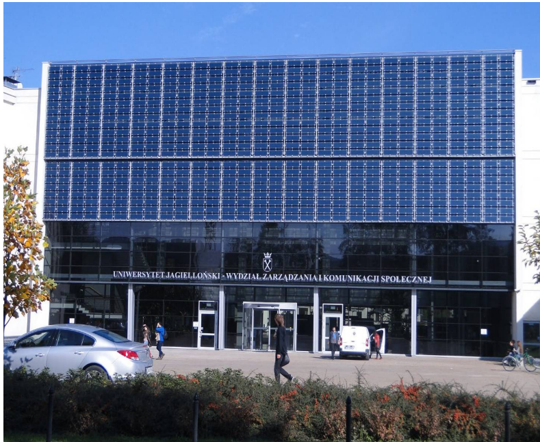
Uniwersytet Jagielloński – Wydział Zarządzania i Komunikacji Społecznej – zainstalowane panele fotowoltaiczne
