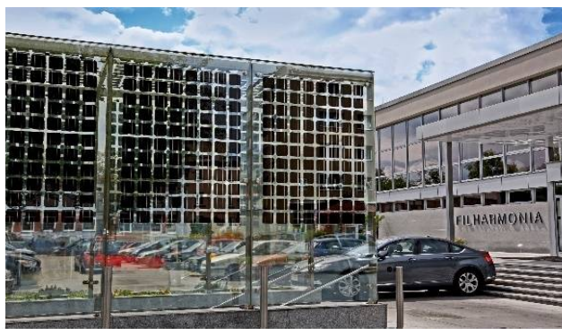
Filharmonia Rzeszów – pierwsza instalacja BIPV
