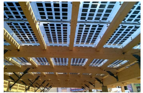
Rynek Jasło – transparentne zadaszenie fotowoltaiczne
