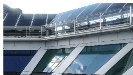
Szpital Uniwersytecki – moduły fotowoltaiczne BIPV
