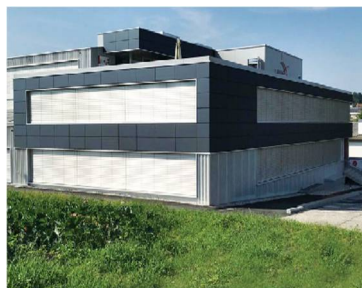
Inwestycja Somiral Energy Supplies SA – fotowoltaiczna fasada wentylowana
