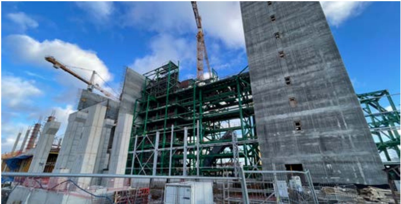
Budowa ITPO w Olsztynie
