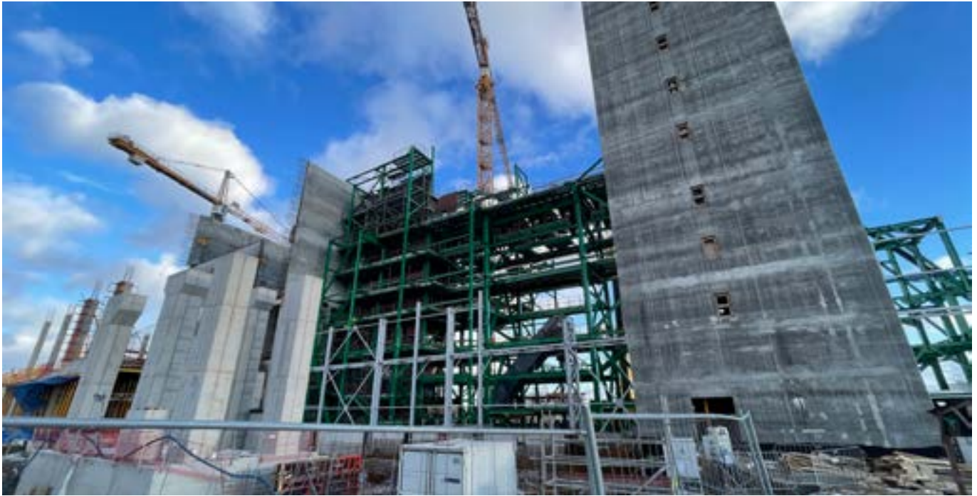
Budowa ITPO w Olsztynie
