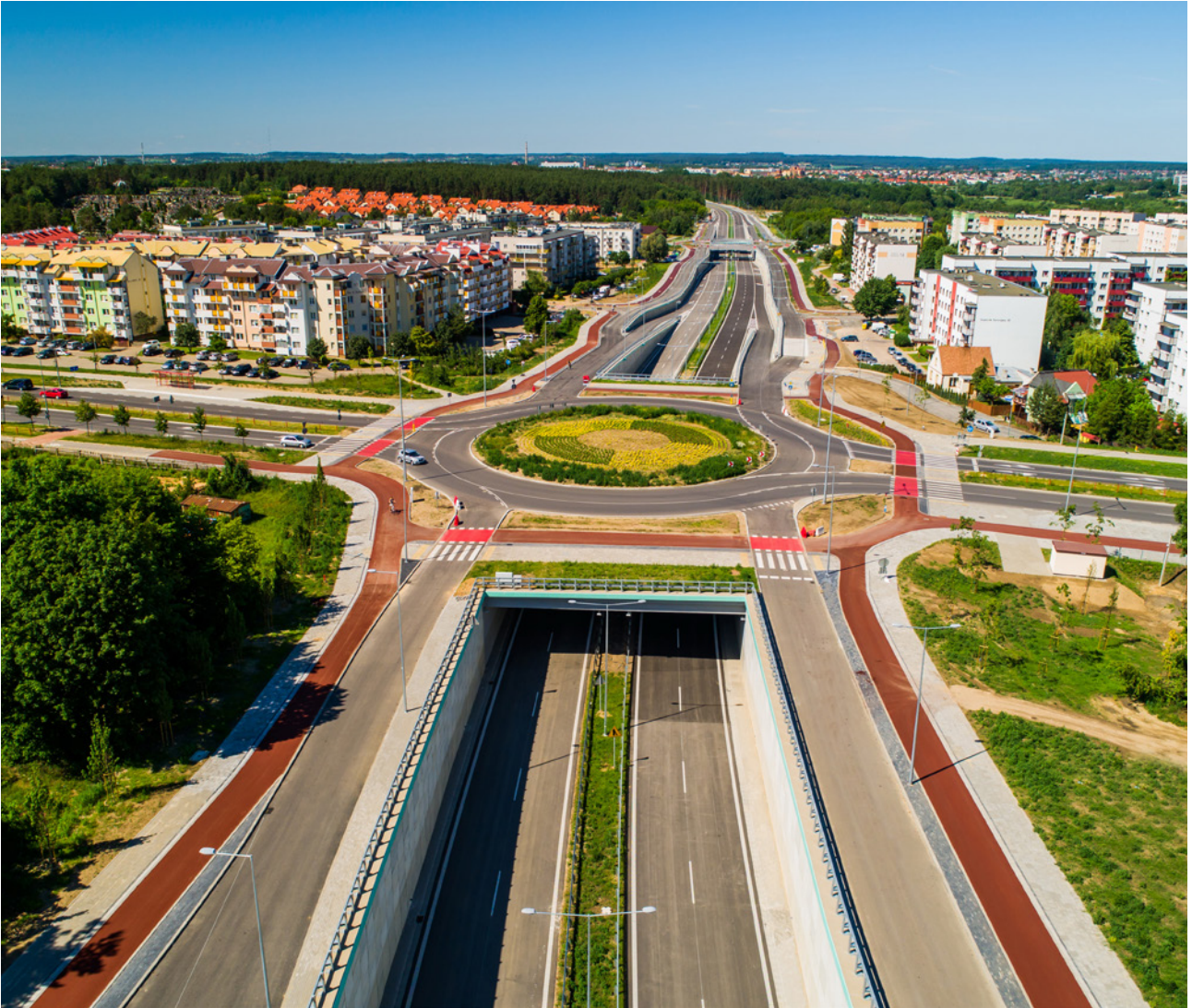
Obiekty mostowe i mury oporowe na Trasie Niepodległości w Białymstoku, Polska
