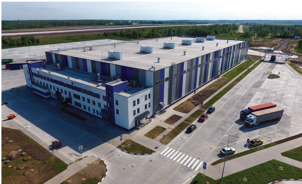
Multimodalny kompleks przemysłowo-logistyczny „Bremino-Orsha” w Bołbasowie, Białoruś
