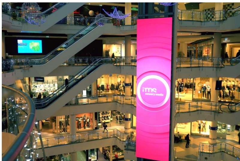
Zdjęcie 3. Instalacja systemu Digital Signage w Blue City
