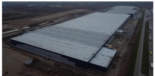
BUDOWA MEDIA EXPERT
