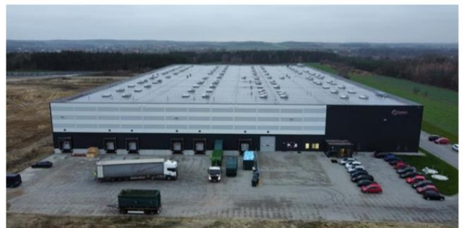
BUDOWA HAL MAGAZYNOWYCH W RAWIE MAZOWIECKIEJ
