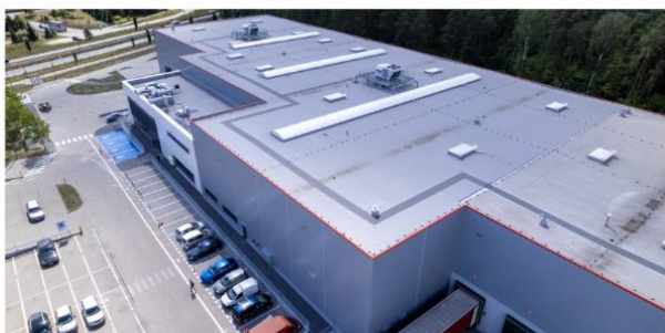
HALA PRODUKCYJNO-MAGAZYNOWA W ŁÓDŹ
