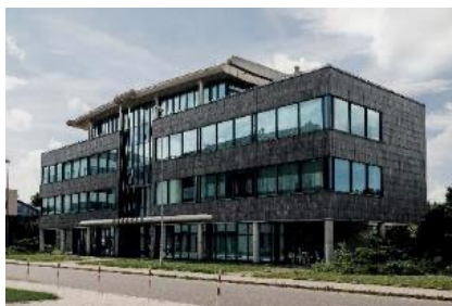
Siedziba AMK Kraków S.A
