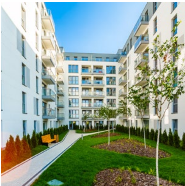
OSIEDLE: PRAHA I, II ETAP (PRAGA POŁUDNIE) 2017
