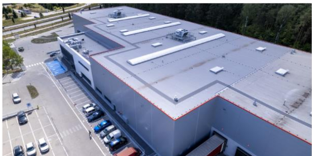
HALA PRODUKCYJNO-MAGAZYNOWA W ŁÓDŹ
