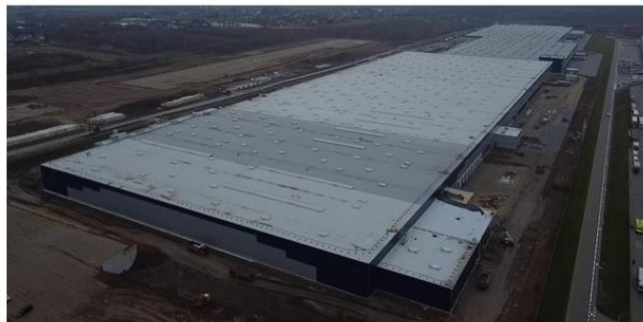
BUDOWA MEDIA EXPERT
