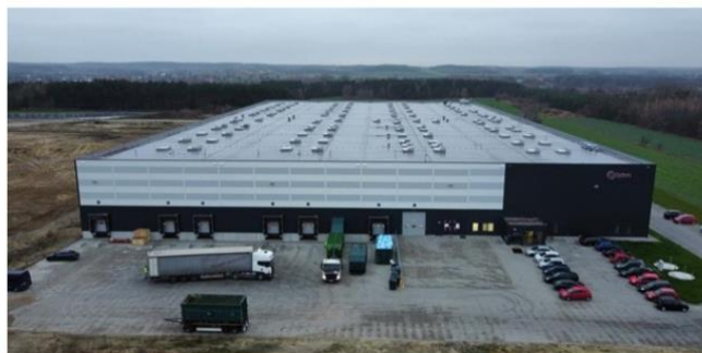
BUDOWA HALI MAGAZYNOWYCH W RAWIE MAZOWIECKIEJ
